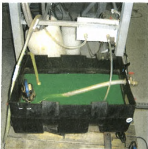
Σχήμα 3.3:α) Δοχείο συλλογής β) Εμβραπτιζόμενη αντλία
