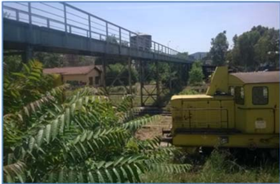
ΕΙΚ.48 Υπέργεια σύνδεση σταθμού και εγκαταλειμμένα βαγόνια
