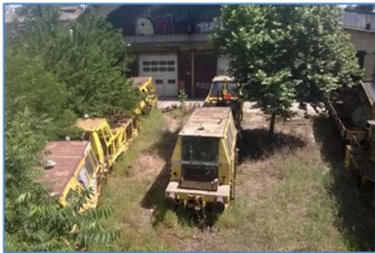
ΕΙΚ.49 Εγκαταστάσεις σταθμού και εγκαταλειμμένα μηχανήματα
