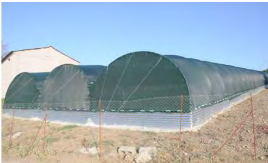
Εικόνα 3.3. Εξωτερική όψη διχτυοκηπίου στην περιοχή Φαρσάλων. (ΠΗΓΗ :Προσωπικό Αρχείο)
