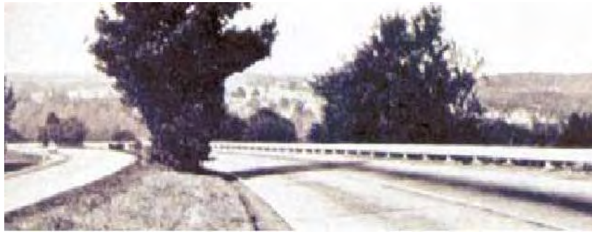
Στηθαία σκυροδέματος D.A.V. στο δεξιό έρεισμα
