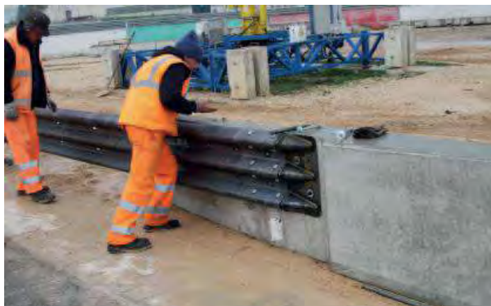
Συναρμογές - Μεταβάσεις (Transitions) στηθαίων ασφαλείας
