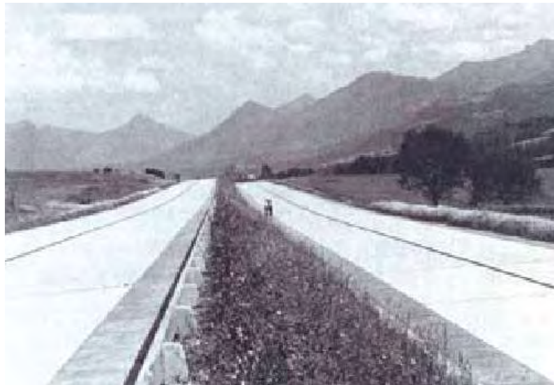
Ξύλινα στηθαία ασφαλείας με πασσάλους από οπλισμένο σκυρόδεμα στον αυτοκινητόδρομο του Μονάχου (Irschenberg)
