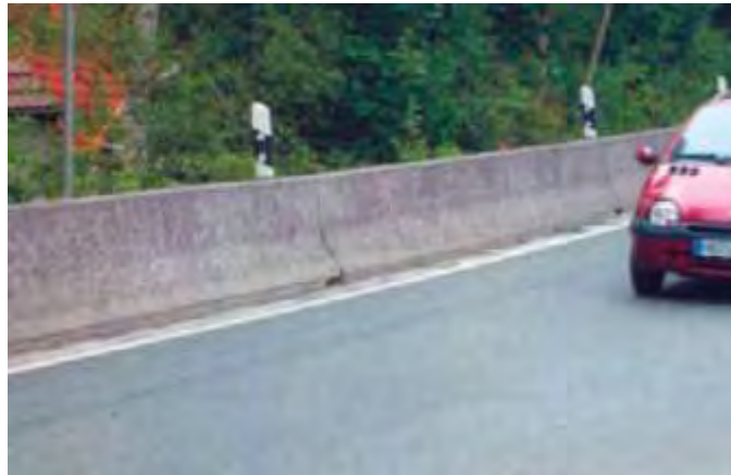
Πρώτη εφαρμογή στηθαίων από σκυρόδεμα με διατομή New Jersey στη Γερμανία (έτος 1980)
