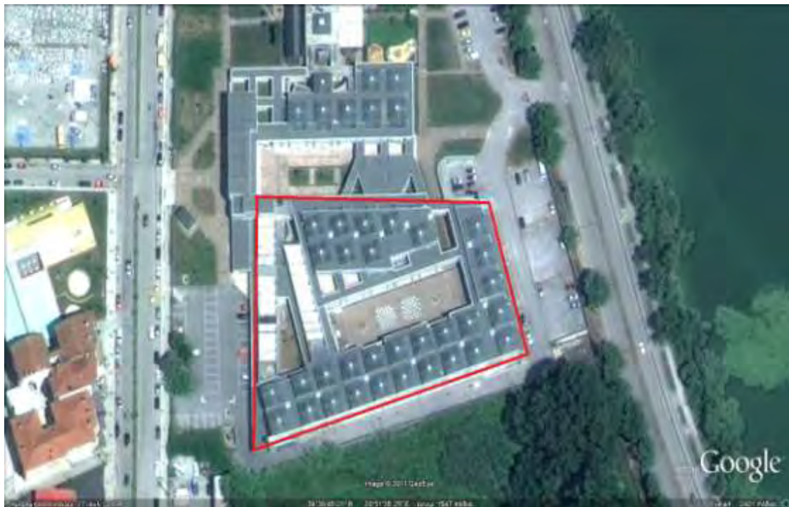
Εικ.8: Το κτίριο του Κ.Ε.Π.Α.Β.Ι. στην Ακτή Μιαούλη ( www.earth.google.com )
