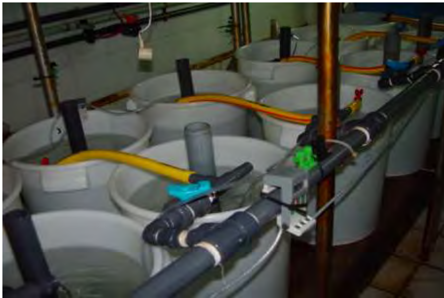
Εικόνα 4.1.1.2.1α. : Πειραματικές δεξαμενές εκτροφής ανοικτής κυκλοφορίας θαλασσινού νερού
