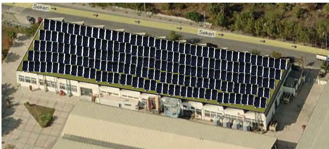
Εικόνα 5.1: Απεικόνιση Φωτοβολταϊκής εγκατάστασης πάνω σε σιδηροκατασκευή
