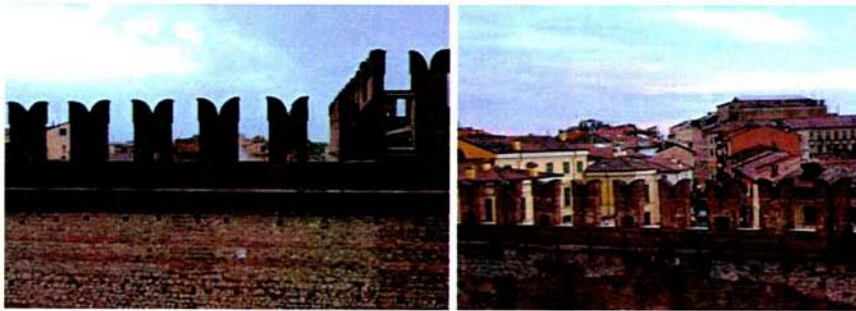
Λεπτομέρειες του άκρου του τοίχου αχυρώσεως στο Castelvecchio πηγή: προσωπικό αρχείο
