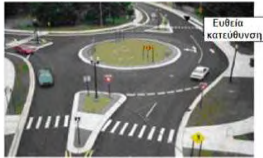
Εικόνα 3-1: Παράδειγμα μεγάλης ακτίνας στην έξοδο 3-σκελούς κόμβου
