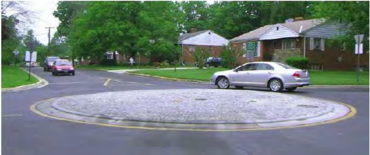
Εικόνα 1.3.1-1: Κομβίδιο κυκλικής κίνησης σε υφιστάμενη διασταύρωση με υπερυψωμένη κεντρική νησίδα
