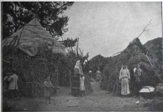
89. *Άριστοτερά στρογγυλό τουρλοκάλυβο γιά τό κατοικιό, χωρίς σκεπή τής κατοσύλας. *Έχουν λοφολέσες τήν κατοσύλα με τρι(γ)ομαλλίσινα τσόλια ή τέντες-σκεπές, γιά νά μη μπαίνουν στό καλύβι τά νεροβρόχια. Δεξιά όσειδες μονές δίπλα καλύβες γιά τό κατοικιό με δίφορη σκεπή πού ξηραίνεις άπ' τό χύμα.
