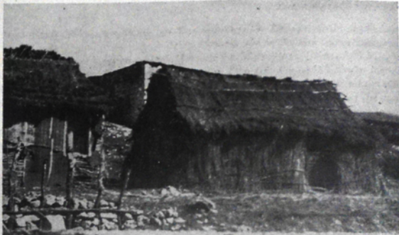
124. *Από σαρακατσάνικη κατασκήνωση που άρχιζει να γίνεται μόνιμη εγκατάσταση.— Μπροστά παραλληλόγραμμο άψιδωτό καλύβι με σαρμασσή στέγη, γινωμένο με άρνιά φουρκές (τρεις μεσιανές και έξι πλαγιανές). Το καλύβι έχει ξελιχθεί σε πλατυμέτωπο και οι άψιδωτές στενές πλευρές του είναι λιγότερο κλιμακώδεις.— Τό άριστοτερό καλύβι δείχνει πού ξελιγμένο τρόπο κατασκευής: τό τοίχωμά του είναι επίσης βρογύπλεστο, αλλά παραγινωμένο με λίσηψη (ξυλόπηχτο). Τή σοβατισμένη έπιφάνειά του συχνά τήν άσβεστόνουν.— Στο βέθος διακρίνεται λιθόχτιστο καλύβι, έτοιμο νά σκαπωτεί με τοίγκο (δύως στήν εικ. 135).
