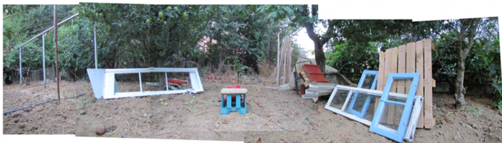
Θέση κατασκευής και προετοιμασία
