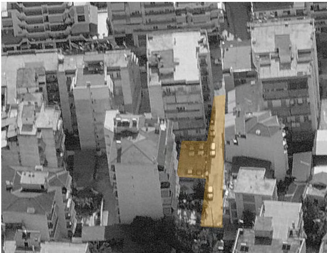
Εικόνες 73,74 : αδιέξοδο - χώρος επέμβασης ( www.bing.com/maps )
