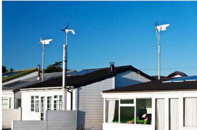
Εικόνα 10 Τοποθέτηση ανεμογεννητριών σε οικίες
