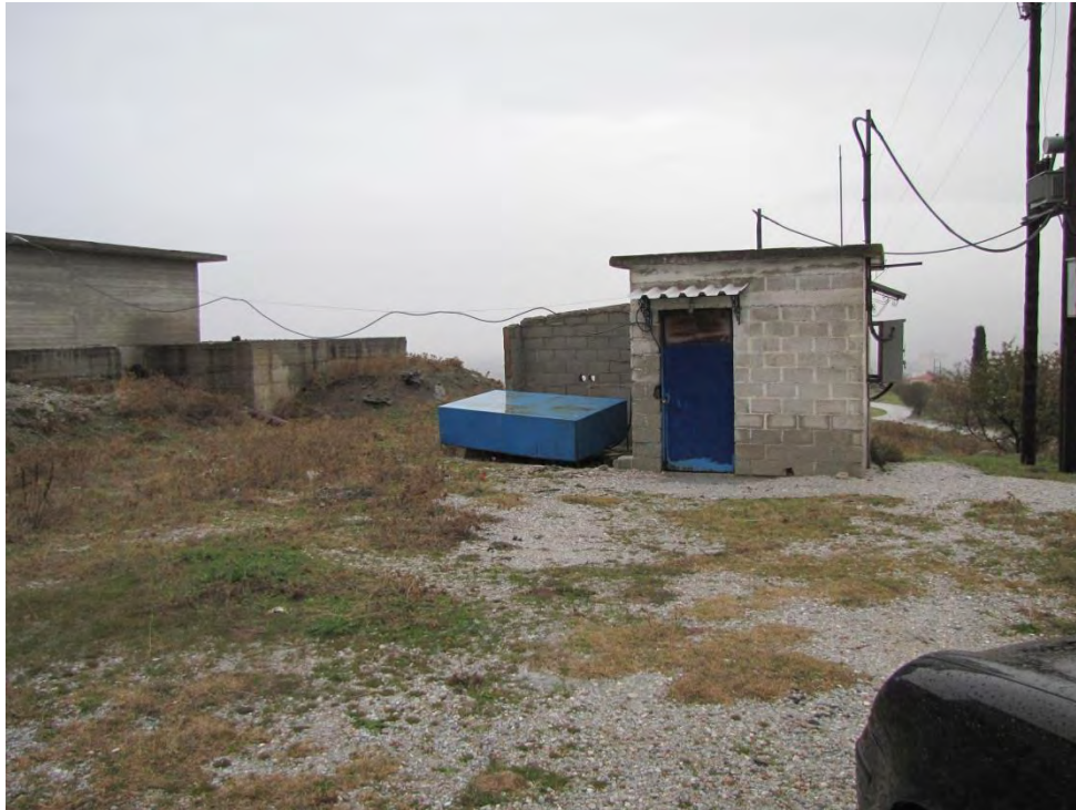
Εικόνα 2: Υδρευτική Γεώτρηση στη περιοχή του Βελεστίνου
