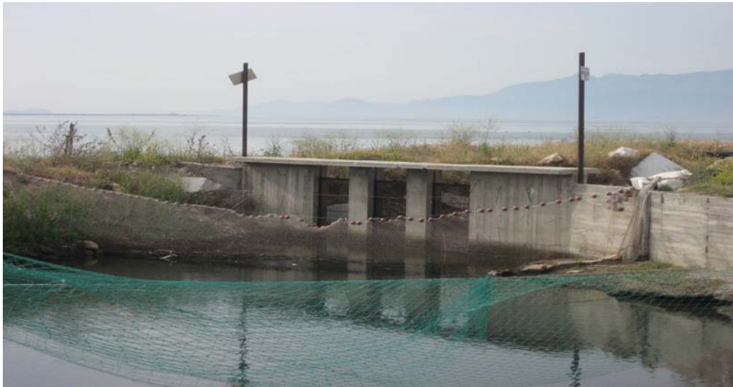
Εικόνα 6 : Φραγμός χωμάτινης δεξαμενής.
