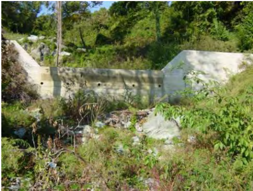
Εικόνα 87: Κατάντη του φράγματος Νο 7
