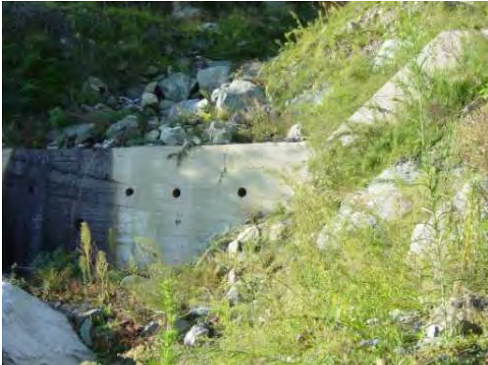
Εικόνα 90: Κατάντη του φράγματος Νο 9
