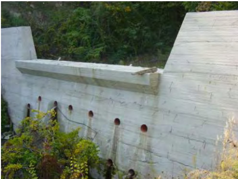
Εικόνα 99: Κατάληξη του φράγματος Νο 15
