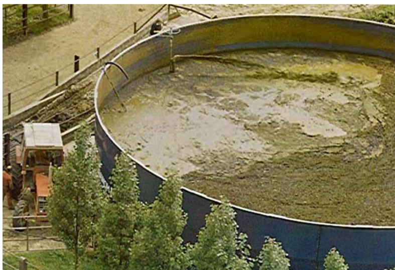
Εικόνα 3-1: Δεξαμενή αποθήκευσης υγρών υποστρωμάτων.
