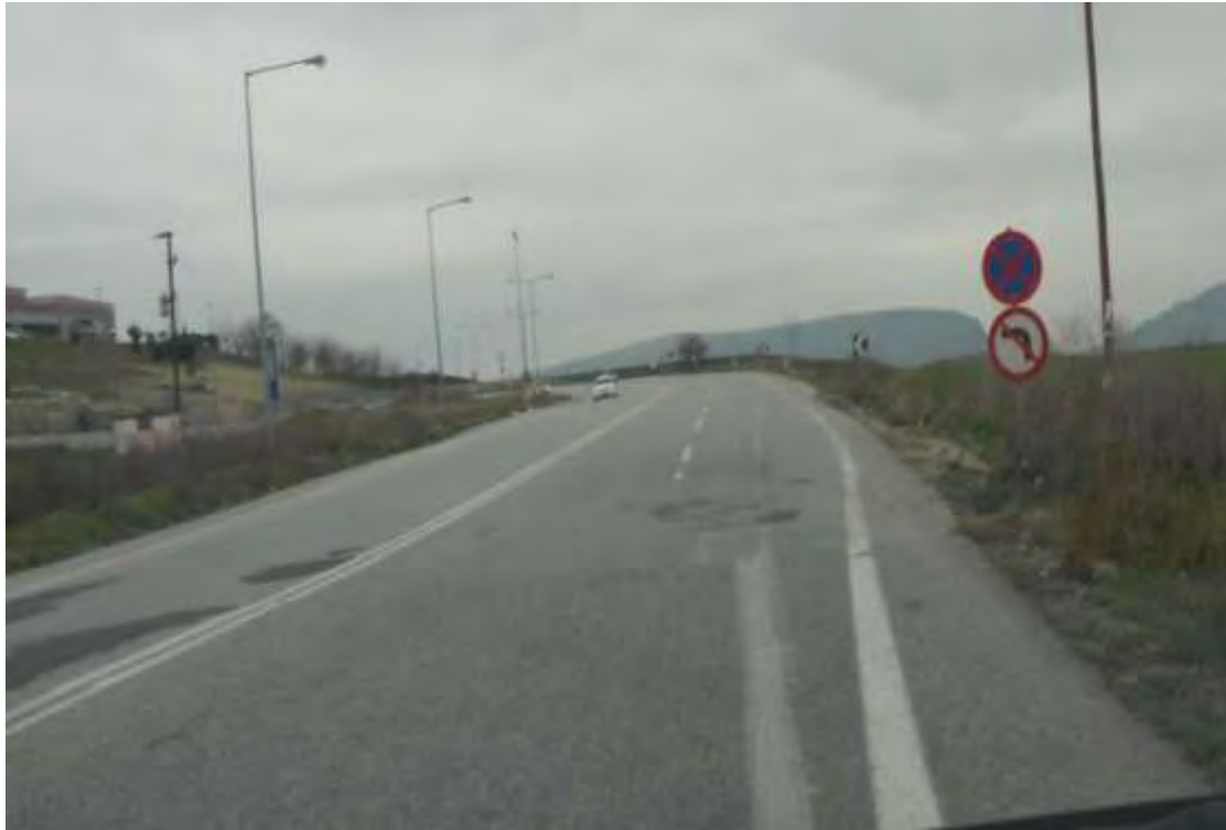
Εικόνα 4.5: Κακή διαμόρφωση οδοστρώματος και Λ.Ε.Α.
