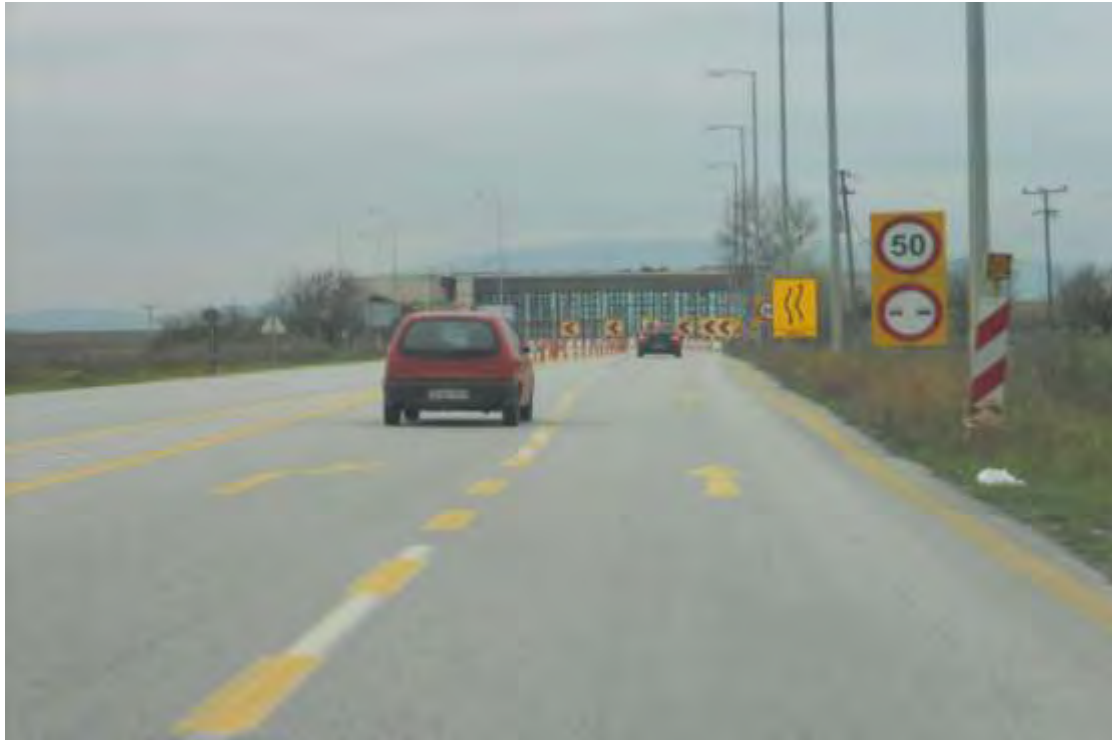
Εικόνα 4.7: Στη χ.θ. 8+270 είσοδος σε εργοταξιακή ζώνη
