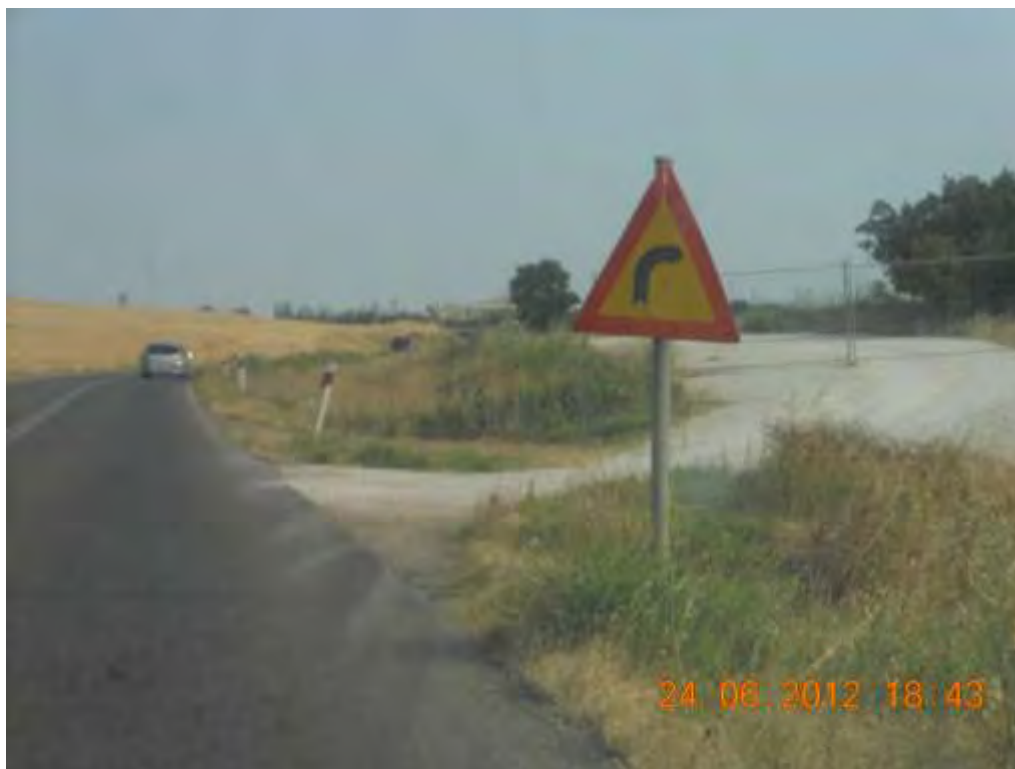
ΕΙΚΟΝΑ 4.4: Χ.Θ. 2+600 – Ισόπεδος κόμβος, απουσία σήμανσης και διαμόρφωσης αριστερόστροφης κίνησης
