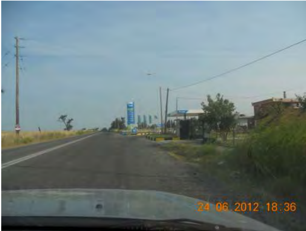
ΕΙΚΟΝΑ 4.1: Χ.Θ. 0+900 – Είσοδος σε βενζινάδικο, έλλειψη διαγράμμισης και σήμανσης
