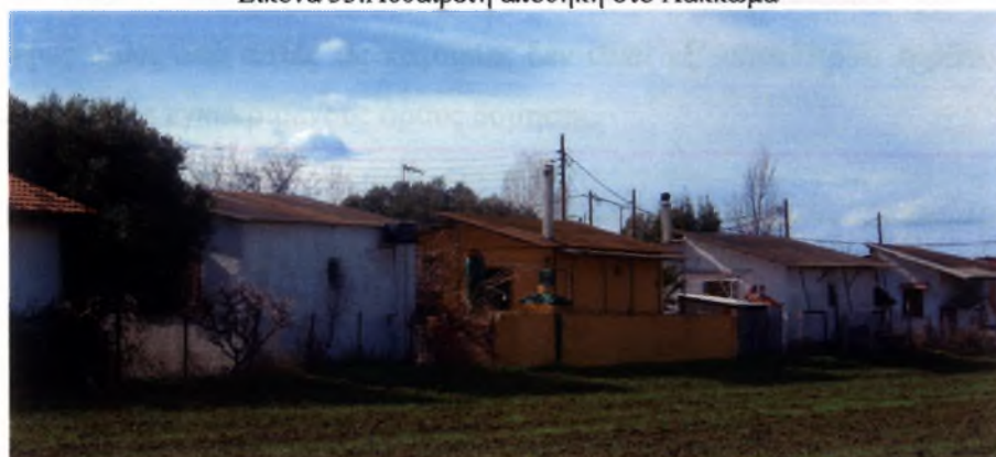
Εικόνα 34: Αυθαίρετες κατοικίες στη Ν. Καλλικράτεια
