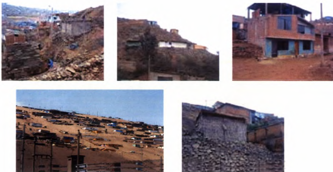
Εικόνα 4-8: Αυθαίρετα κτίσματα στη Λίμα
