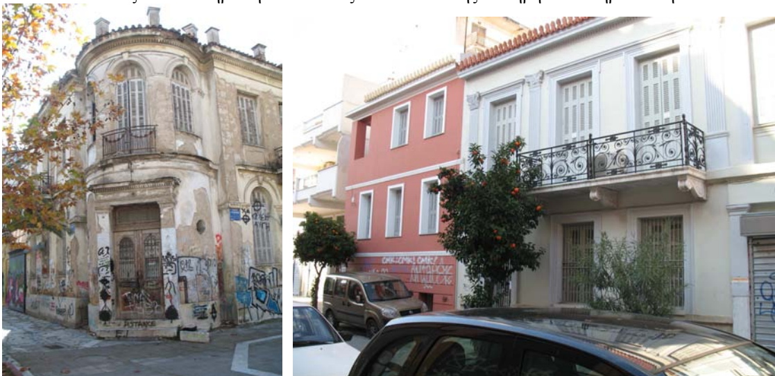
Εικ. 106, 107 Αριστερά: Διατηρητέο στη συμβολή Σαλαμίνας και Παραμυθιάς Δεξιά: Ολοκλήρωση διαδικασίας αποκατάστασης διατηρητέων κτηρίων στην Πλαταιών
