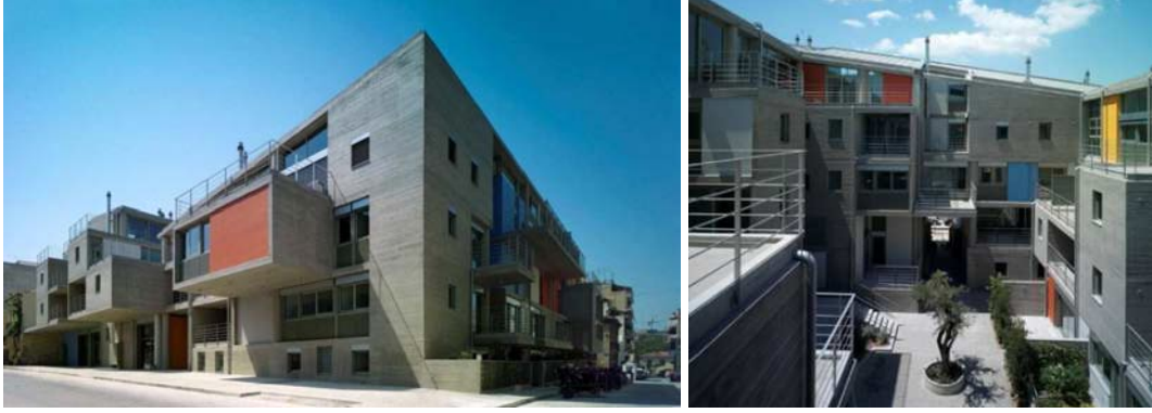
Εικ. 115 - 119 Συγκρότημα κατοικιών και καταστημάτων της ΓΕΚ- ΤΕΡΝΑ ΑΕ επί της Μυλλέρου
