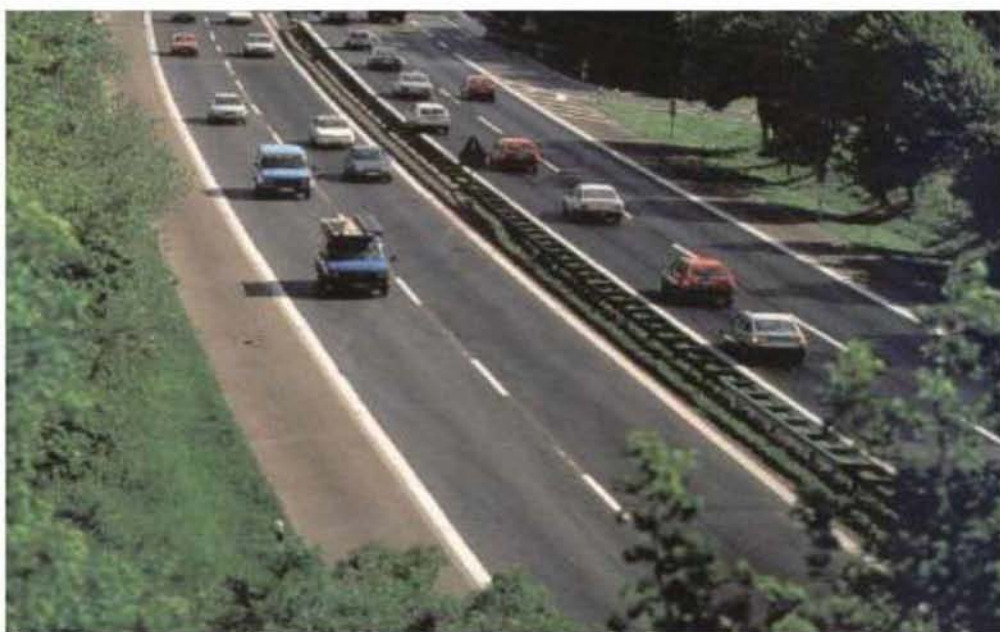
Εικόνα 3 Ενισχυμένο αμφίπλευρο στηθαίο σε ενδιάμεσο χώρο αυτοκινητόδρομου
