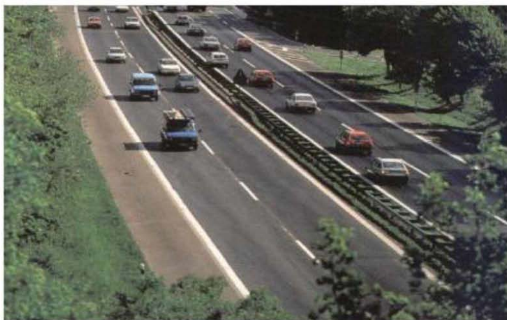
Εικόνα 3 Ενισχυμένο αμφίπλευρο στηθαίο σε ενδιάμεσο χώρο αυτοκινητόδρομου
