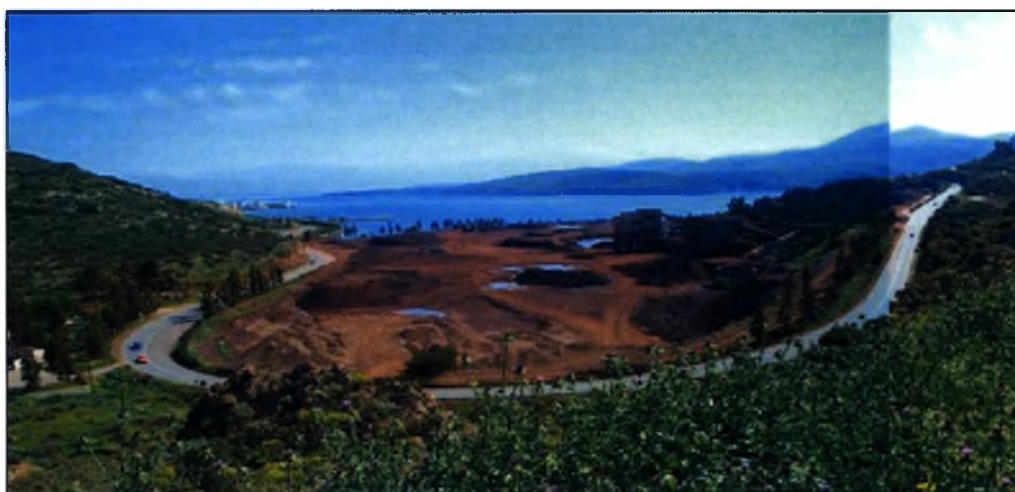
Εικόνα 6.1: Νότια πανοραμική άποψη των εγκαταστάσεων. Διακρίνεται η διερχόμενη Ε.Ο. Ιτέας – Γαλαξειδίου, καθώς και ο οικισμός της Ιτέας στο βάθος
