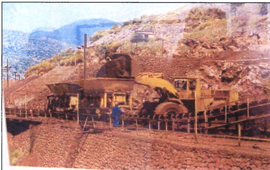
Εικόνα 6.5: Άποψη της πλατείας φόρτωσης και τροφοδοσία με φορτωτή
