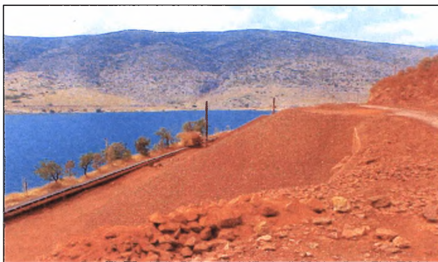
Εικόνα 6.4: Άποψη της πλατείας φόρτωσης
