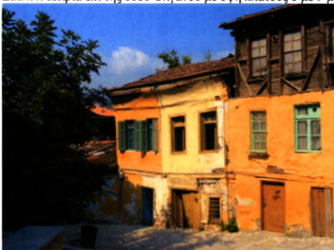
Εικ.4.4: Κτίρια επι της οδού Ολγάνου με όψη πλάτους 6 με 9 μέτρα.
