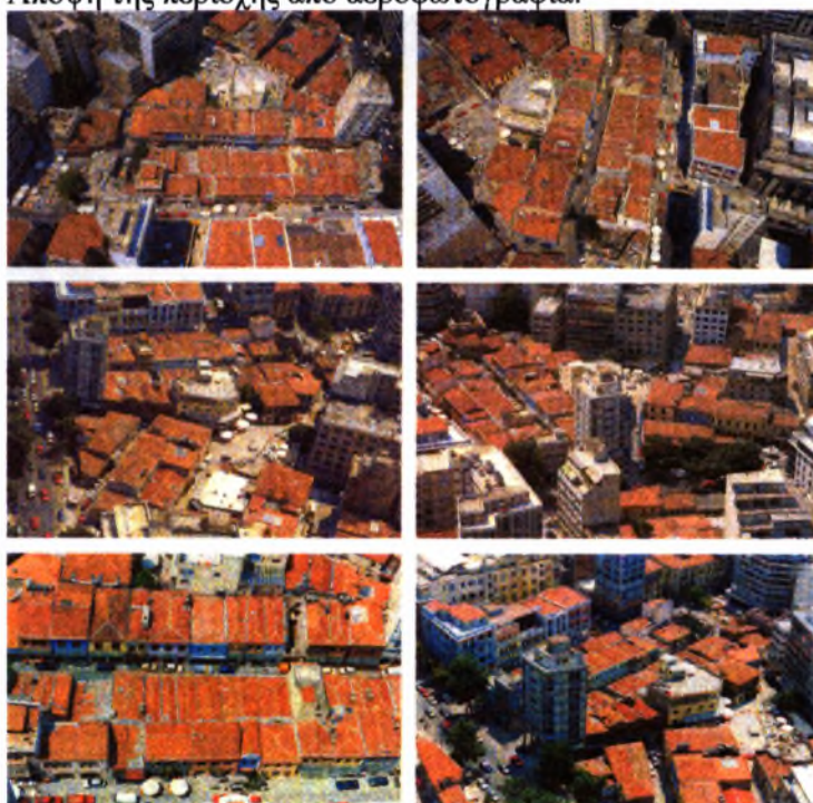
Εικ.6.4: Το κτιριακό σύνολο του πυρήνα των Λαδάδικων. Άποψη της περιοχής από αεροφωτογραφία.
