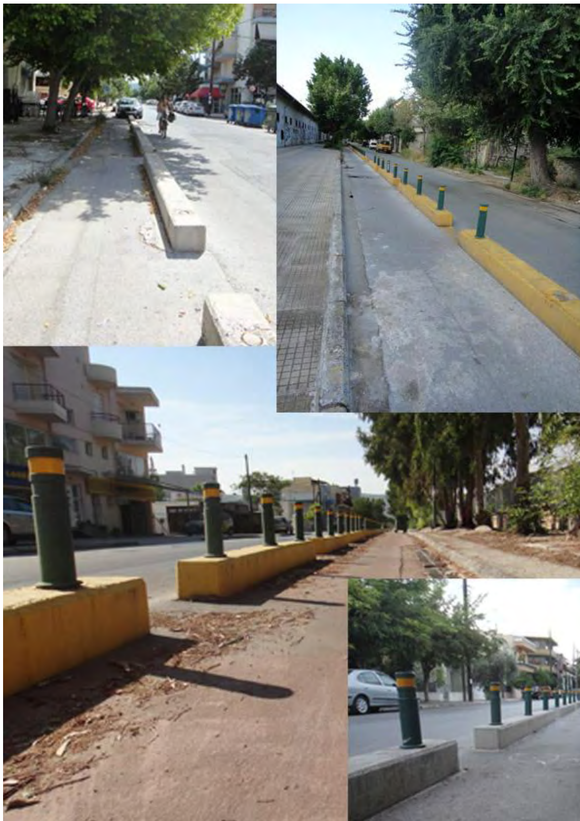
Εικόνα 4: Νησίδες σκυροδέματος με διαφορετικά χαρακτηριστικά
