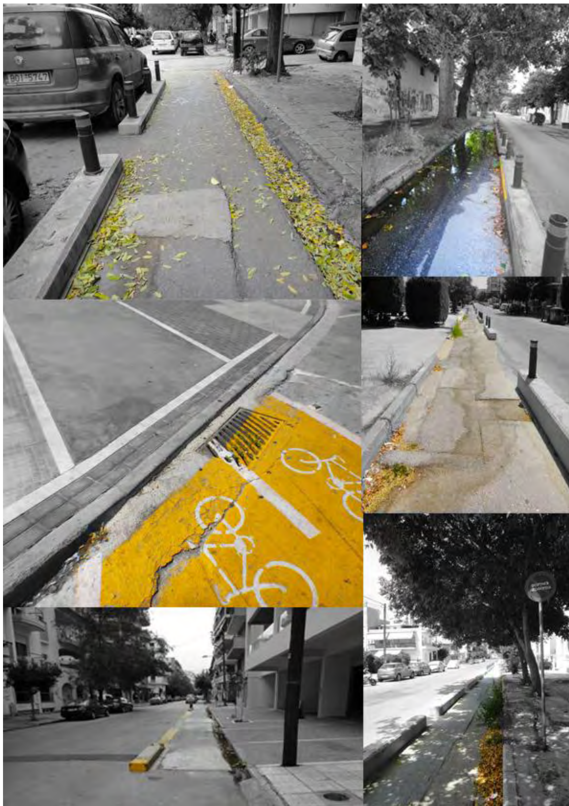
Εικόνα 8: Μη ομαλές επιφάνειες δικτύου ποδηλατοδρόμων
