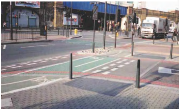
Εικόνα 4.8: Διασταύρωση οδών όπου οι ποδηλάτες έχουν προτεραιότητα απέναντι στην κάθετη οδό μονής κίνησης
