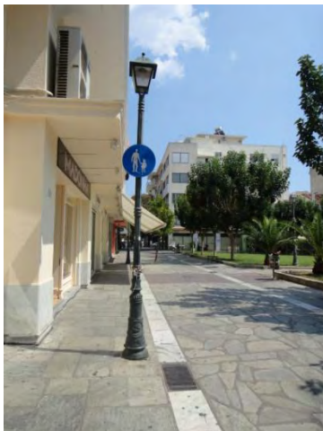
Εικόνα 5.3: Κάθετη σήμανση επί της οδού Ερμού με Π. Μελά
