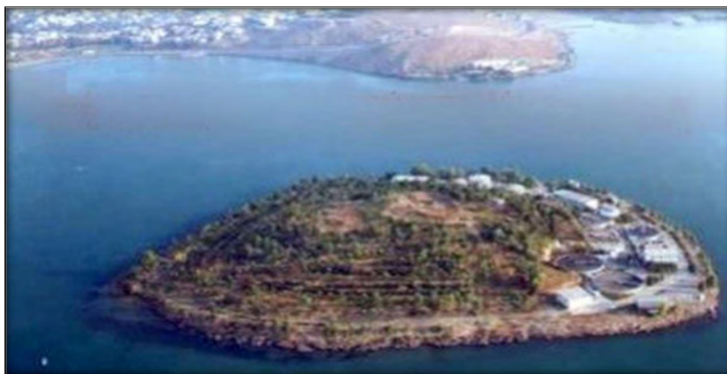
Εικόνα 15: Εγκατάσταση επεξεργασίας υγρών αποβλήτων στην Χαλκίδα μετά την ανάκτηση εκροών (Νήσος Πασάς)
