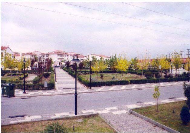
Εικόνα 41, Άποψη του συγκροτήματος κατοικιών "Μελίνα Μερκούρη"
