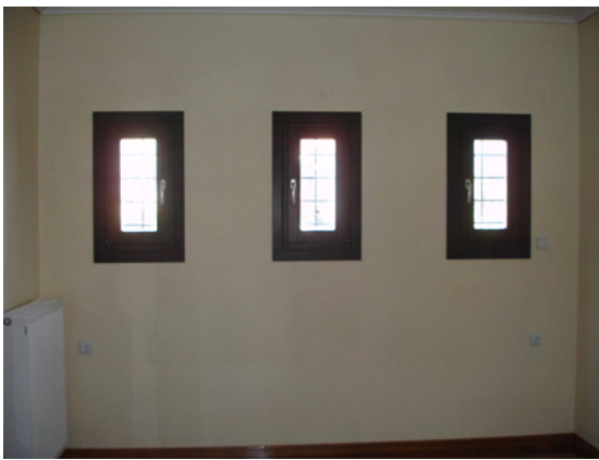
Εικόνα 141, Παραδοσιακά υλικά κατασκευής σε μεμονωμένη προαστιακή κατοικία
