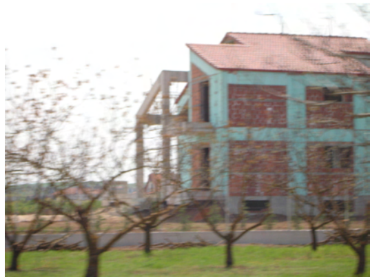
Εικόνα 94, κατοικία στη φάση της κατασκευής
