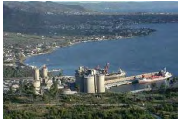
Εικόνα 134, Το εργοστάσιο της ΑΓΕΤ
