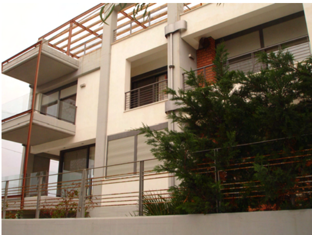
Εικόνα 5, Εξώστες και ημιυπαίθριοι χώροι κατοικίας
