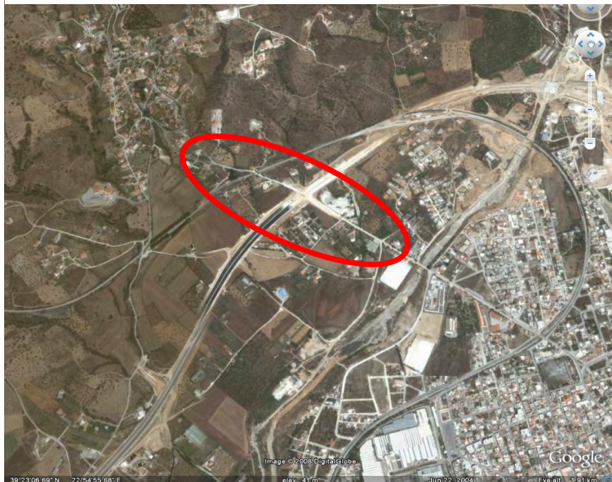
Εικόνα 11, Αεροφωτογραφία του ενδιαμέσου χώρου στα Μελισσάτικα
