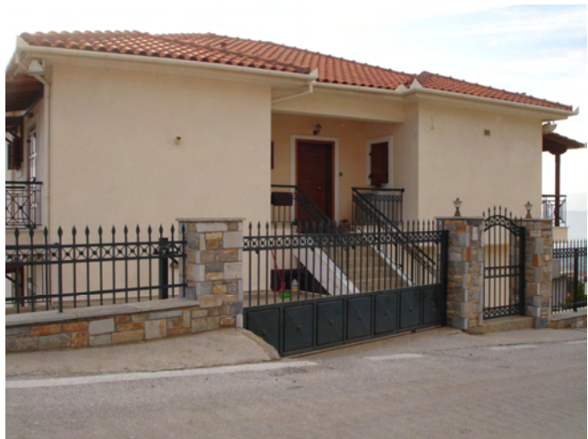
Εικόνα 139, Κεντρική τοποθέτηση της εισόδου
