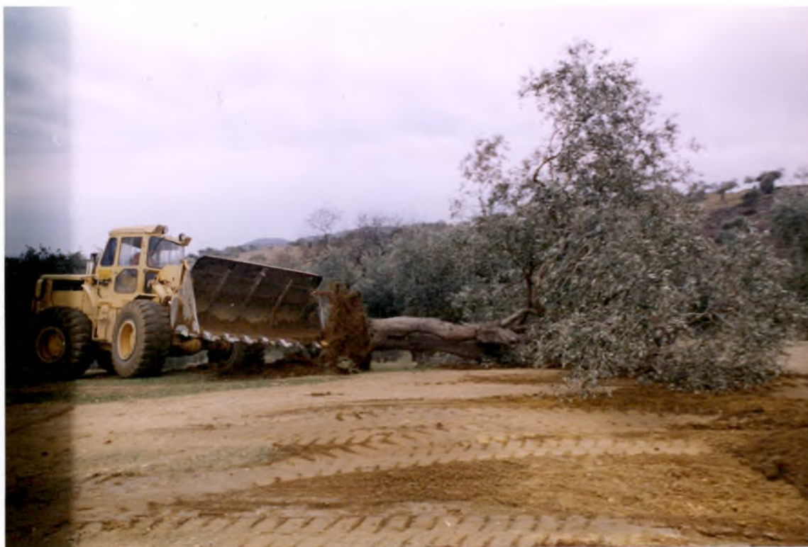
Φωτογραφία 1 : Λιάνοιξη οδού στο αραιοδομημένο τμήμα Λιμεναρίων-Τομέας Γ'
