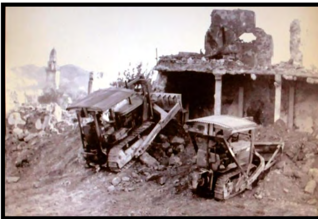
Εικόνα 3.5. : Οι κρατικές μπουλντόζες κατεδαφίζουν άκριτα τα μισογκρεμισμένα κτήρια της Χώρας. (Προσωπικό Αρχείο Α. Στάβερη)
