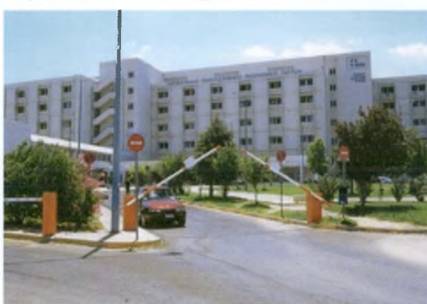
Φωτογραφία 6.2: Πανεπιστημιακό Νοσοκομείο Ρίου
