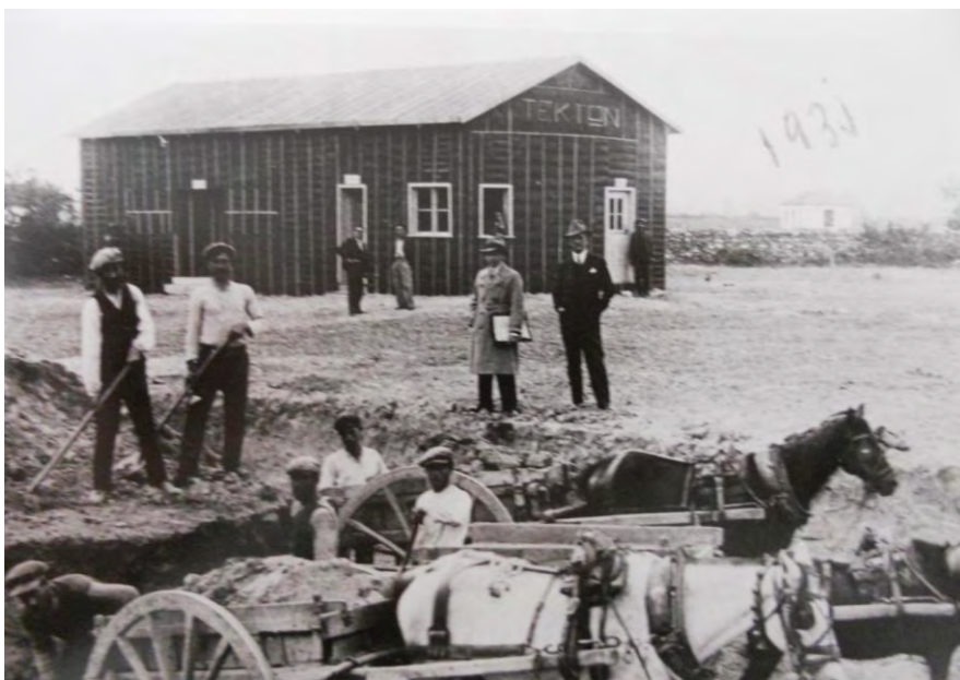
Καλαμαριά 1931. (Πηγή: Ιστορικό Αρχείο Προσφυγικού Ελληνισμού ) Το κτίριο που στέγαζε τα γραφεία της οικοδομικής εταιρείας «ΤΕΚΤΩΝ». Μπροστά, εργάτες της εταιρείας που κατασκευάζουν σπίτια για τους πρόσφυγες
