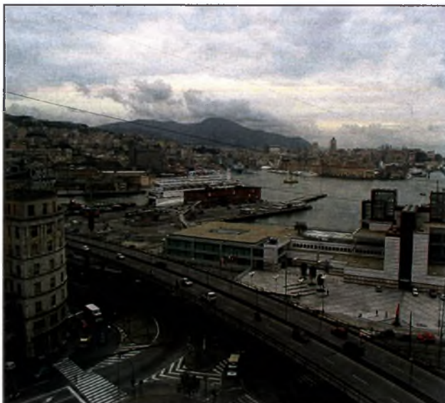
Εικόνα 2.6.1.1: Υπερυψωμένη λεωφόρος κατά μήκος του θαλάσσιου μετώπου
