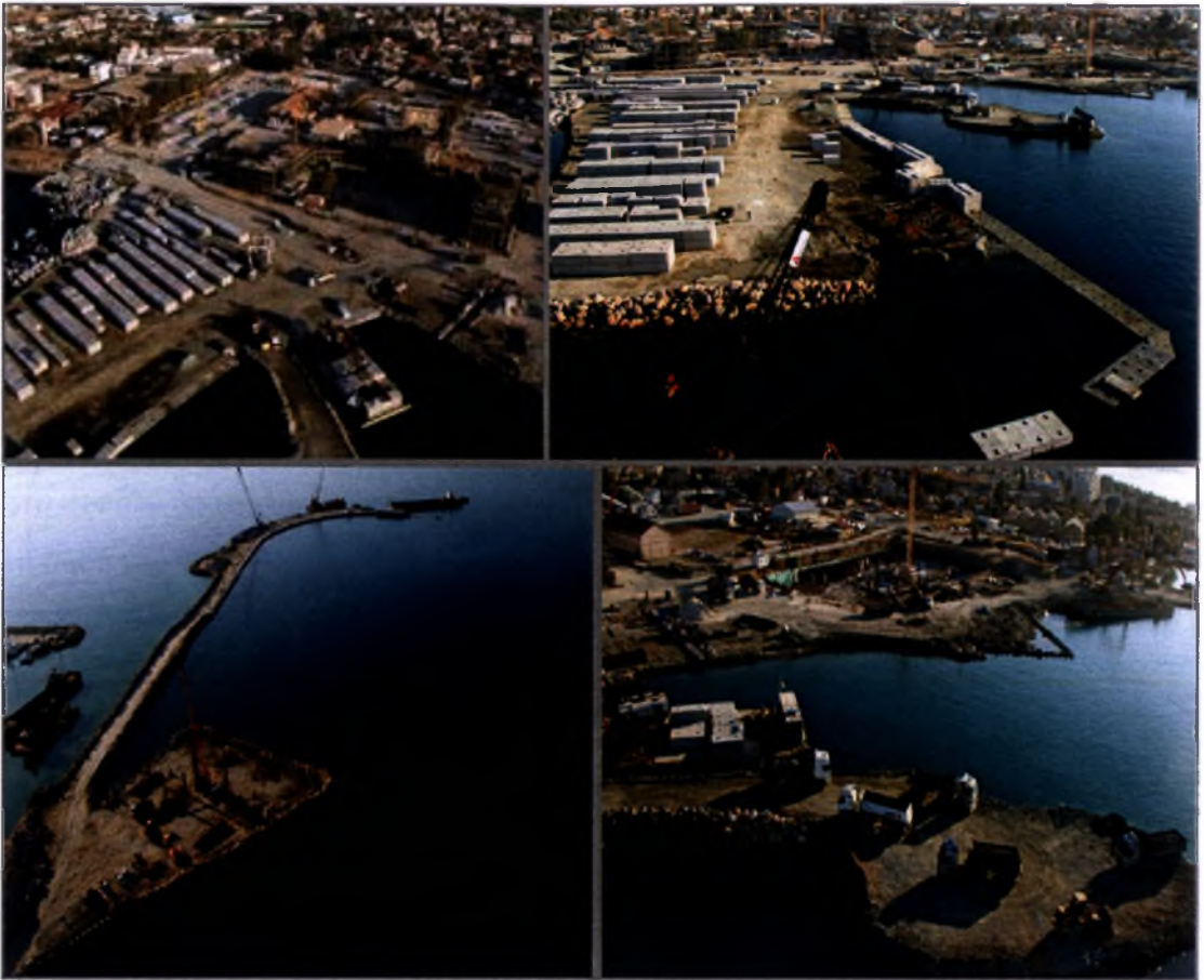
Εικόνα 4.4.2: Υπό εξέλιξη κατασκευαστικά έργα
