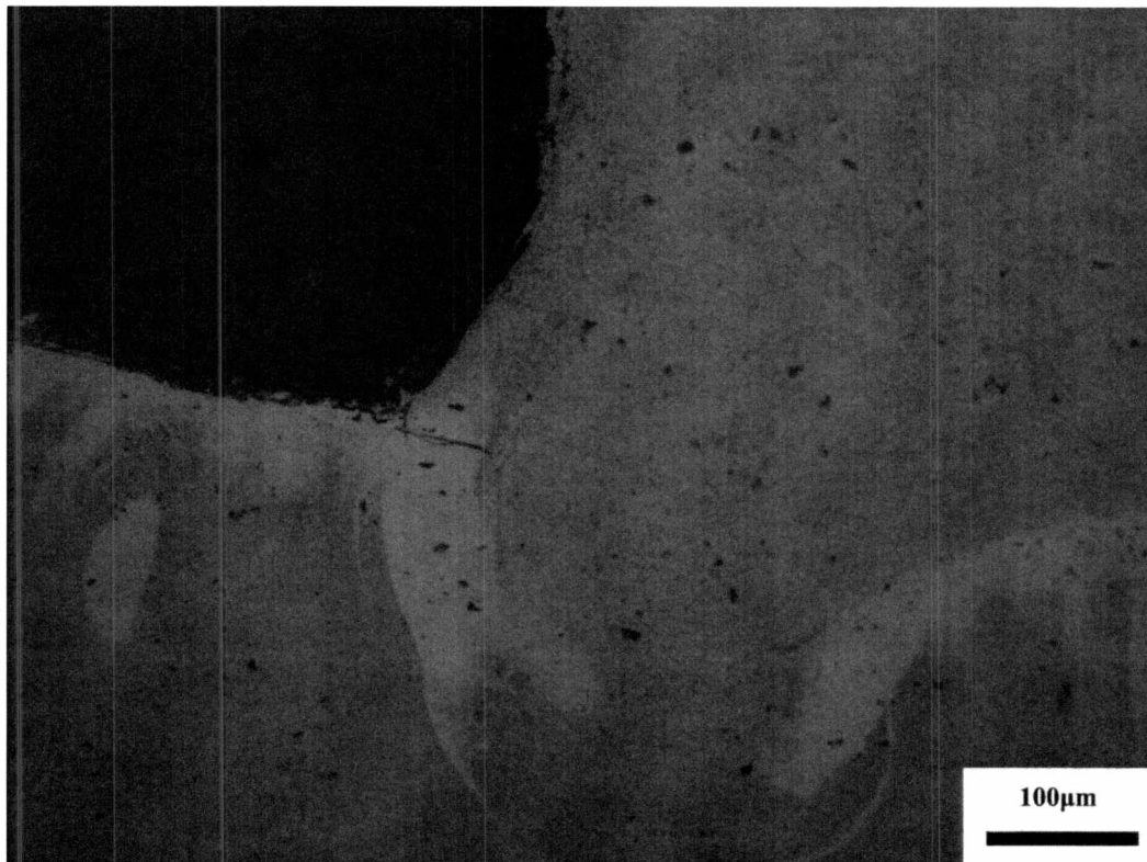
Σχ. 4.9: (KL 7-3-02) Περιοχή Α, Σχήματος 4.8, περιοχή έναρξης ρωγμής κόπωσης μέσα στο clad layer.
