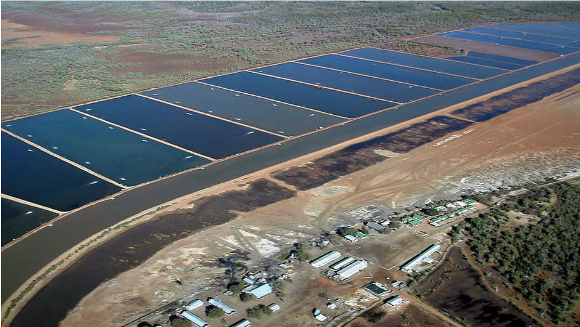
Εικόνα 2. Υπερσύγχρονη μονάδα εντατικής εκτροφής γαρίδας.
