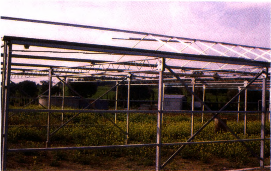
Εικόνα 1.3 Ενίσχυση ακραίων μονάδων με αντιανέμια
