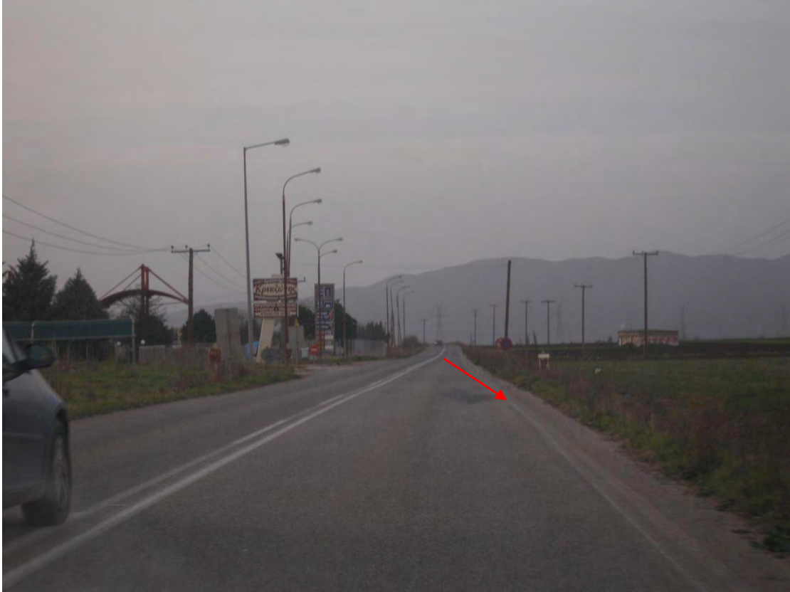
Εικόνα 5.5: Χαρακτηριστική ευθυγραμμία με μικρό έρεισμα και φθαρμένη λωρίδα εσωτερικής καθοδήγησης. Συναντάται κατά κόρου στο εξεταζόμενο δίκτυο.
