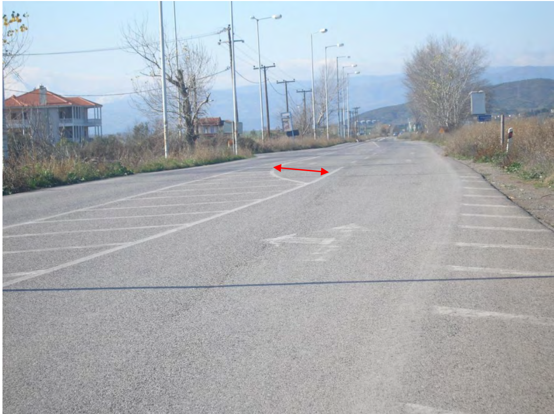
Εικόνα 5.6: Ισόπεδος κόμβος Χ.Θ. 7+500, με διαμόρφωση αριστερόστροφων κινήσεων
