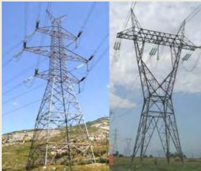
Εικόνα 11:Στύλοι 400 kV[16]
