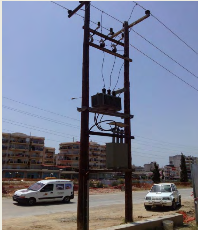
Εικόνα 15:Εναέριος Υ/Σ διανομής στη Θεσσαλονίκη[1]
