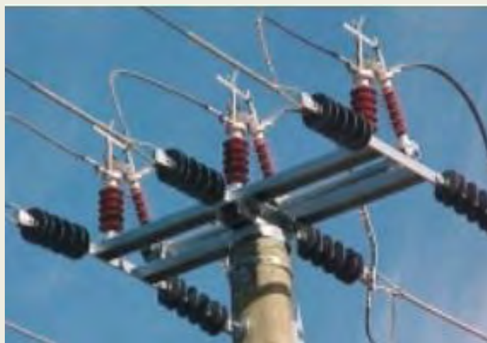
Εικόνα 12:Μονωτήρες σε εναέρια γραμμή[17]
