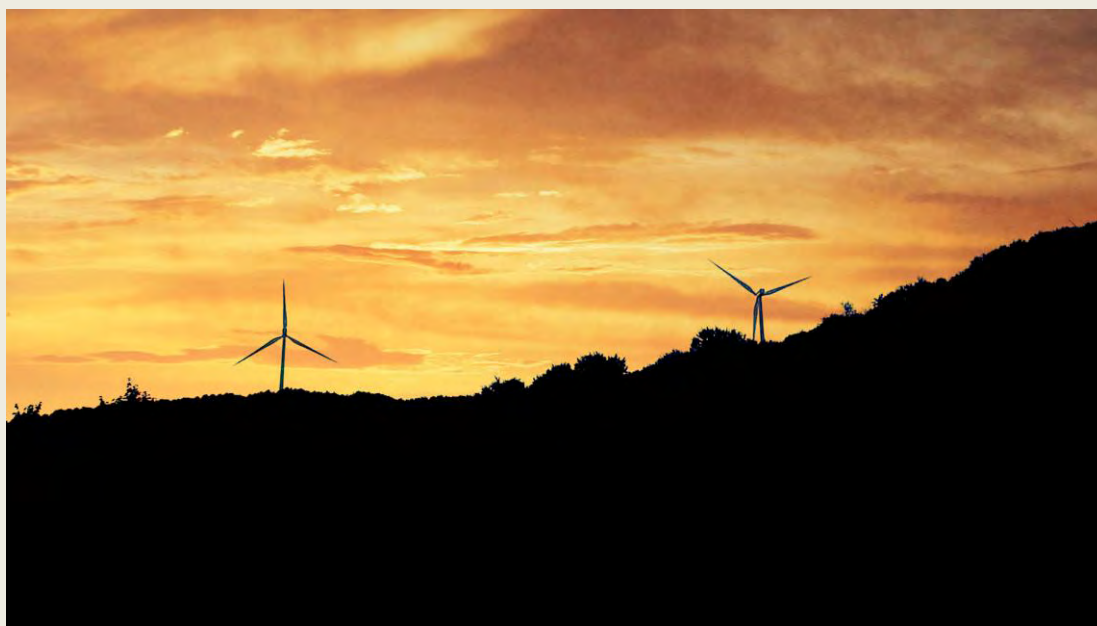
Εικόνα 4: Αιολικό πάρκο στην Παναγία Σουμελά Δ.Βέροιας ισχύος 14MW[1]
