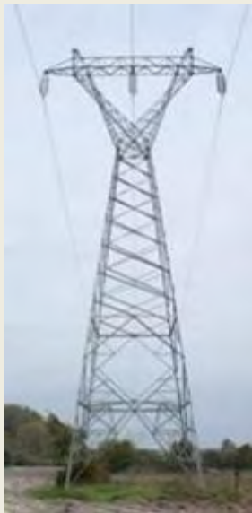
Εικόνα 10:Στύλοι 150 kV[16]
