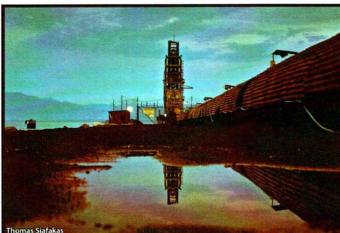
Εικόνα 3.1.2.2: Εγκαταστάσεις Συγκροτήματος Θραύσης Βωξίτη, Αγία Μαρίνα Φθιώτιδας
