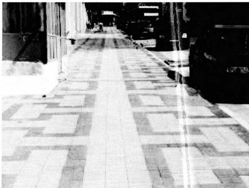
Εικόνα 9.1 Τοποθέτηση κυβόλιθων και πλακών κατά μήκος του πεζοδρομίου (Πηγή: www.giannitsa.gr )
