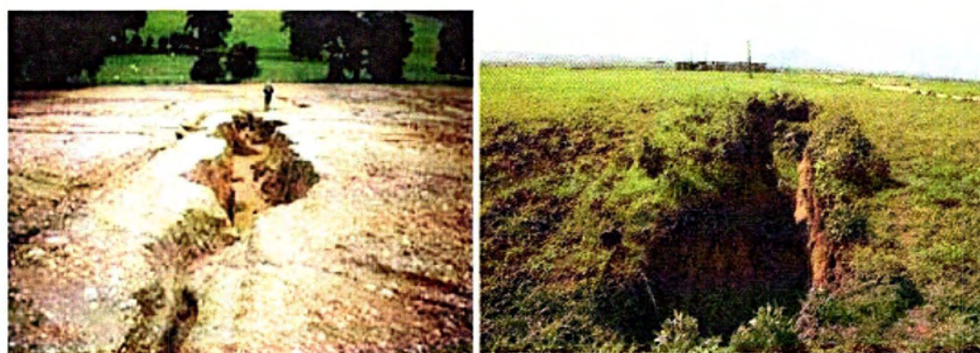
Εικόνα 18 : Η κατάσταση του εδάφους μετά την αποξήρανση
