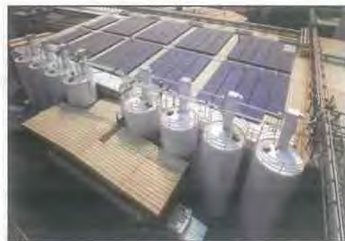
Σχήμα 1- 11: Ηλεκτρικός σταθμός παραγωγής ενέργειας με κυψέλες καυσίμου ισχύος 1.2 MW στη βιομηχανία ζυθοποιίας SIERRA NEVADA BREWING CO.[17]
