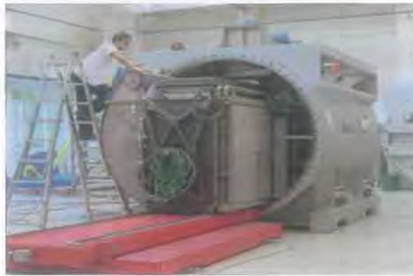
Σχήμα 1-6: Μονάδα ισχύος Κυψελών Καυσίμου Τηγμένων Ανθρακικών Αλάτων σε κέντρο δεδομένων της εταιρείας T-Mobile, στο Μόναχο [29].
