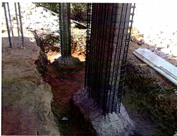
Εικόνα 7.5 Παράδειγμα αγκύρωσης οπλισμού υποστύλωματος πάνω σε πέδιλο
