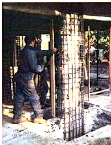
Εικόνα 7.3 Τοποθέτηση καλουπιών
