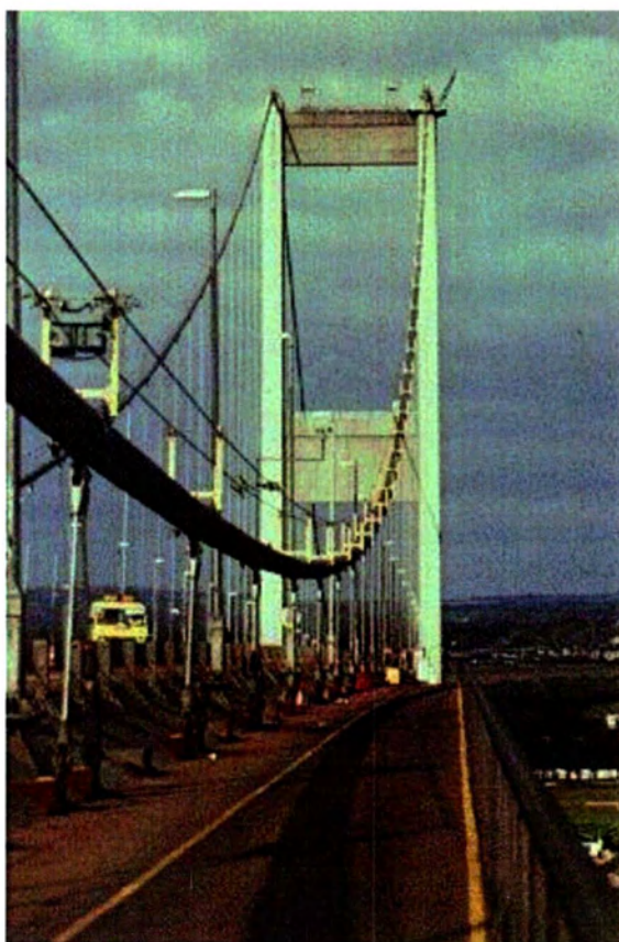
Εικόνα 20: Η γέφυρα Severn μετά την ολοκλήρωση της κύριας ενίσχυσης
