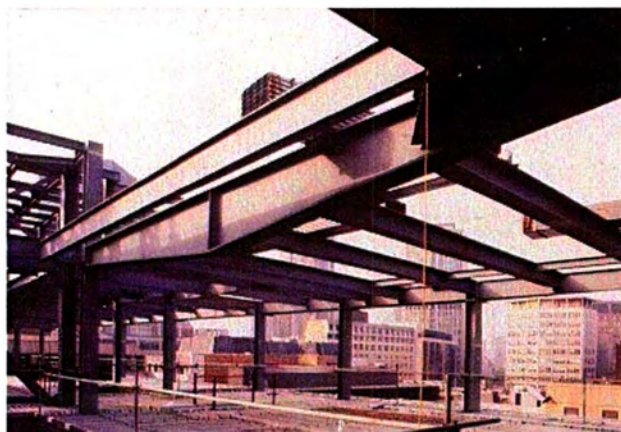
Εικόνα 12: Συστήματα δαπέδων μεγάλων ανοιγμάτων για κτίρια γραφείων - 2
