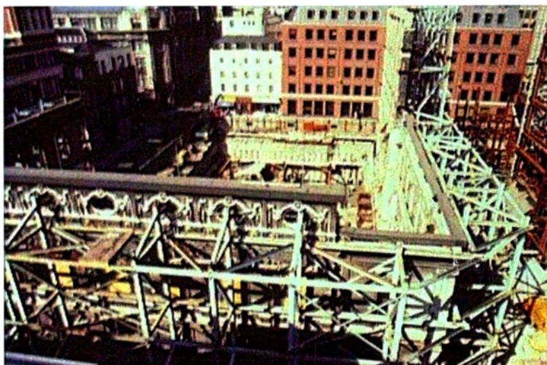
Εικόνα 19: Ανακατασκευή πίσω από διατηρημένες προσόψεις
