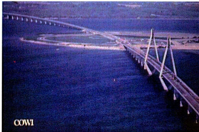
Εικόνα 4: Γέφυρα Faro, Δανία
