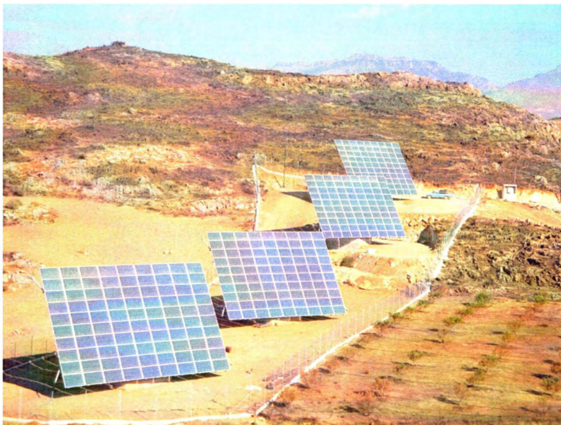
Εικόνα 1.7 Φωτοβολταϊκός σταθμός εγκατεστημένης ισχύος 637,2kW με ηλιοστάτες 2 αξόνων έξω από το Ρέθυμνο.
