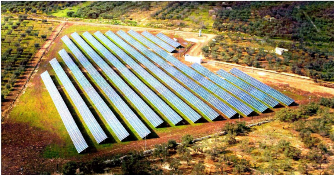
Εικόνα 3.23 Φωτοβολταϊκός σταθμός εγκατεστημένης ισχύος 1 MW στην Ιταλία.
