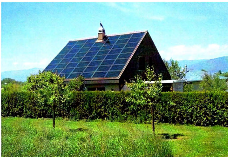
Εικόνα 1.2 Εφαρμογή Φ/Β συστήματος σε στέγη στην ύπαιθρο.
