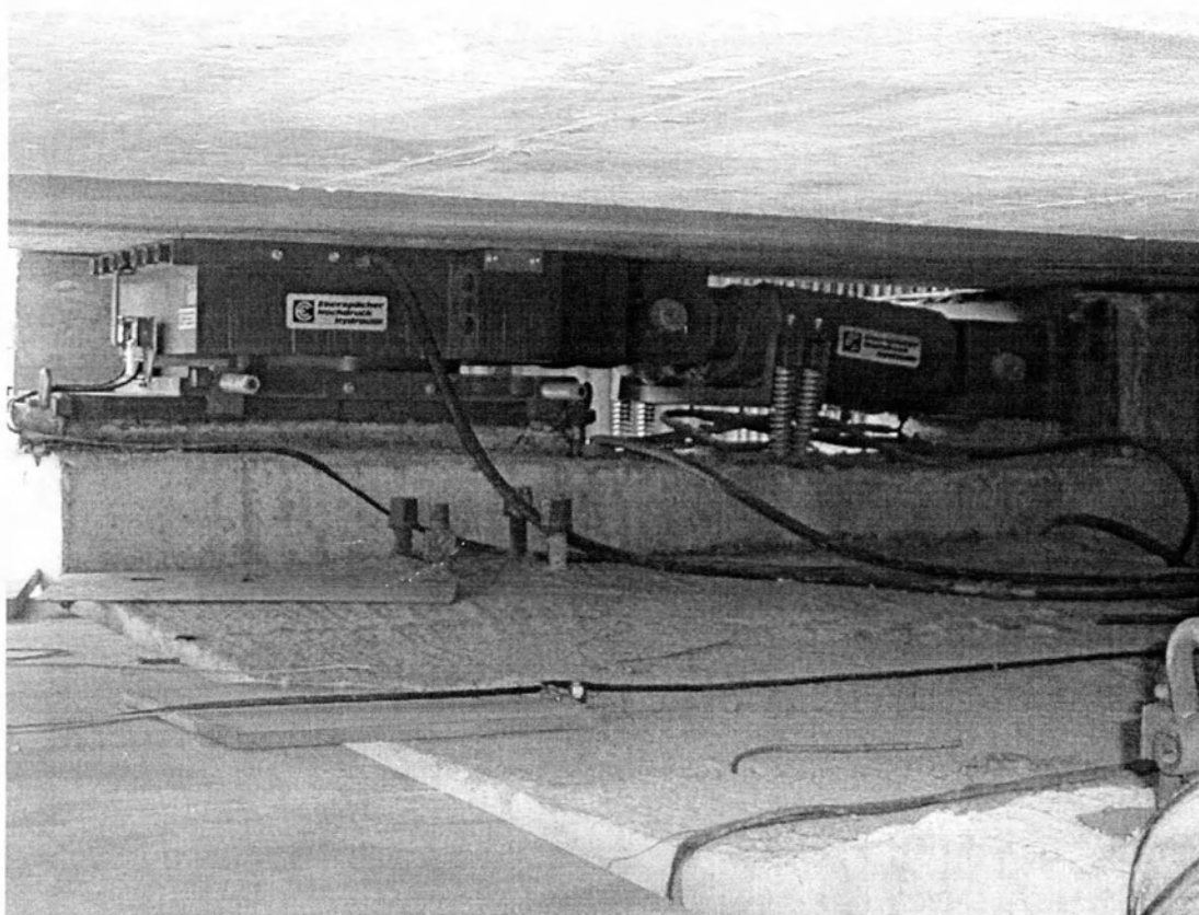
Φωτογραφία 3.4.6 Προωθητήρας τριβής και γρύλλος ανύψωσης
