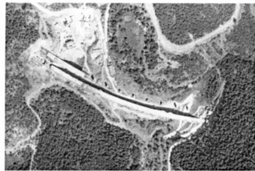
Σχήμα 3.1.1 απόσπασμα από τη χάραξη της ΕΟ στον δυτικό τομέα Σχήμα 3.1.2 αεροφωτογραφία κατά τη φάση κατασκευής του αριστερού κλάδου
