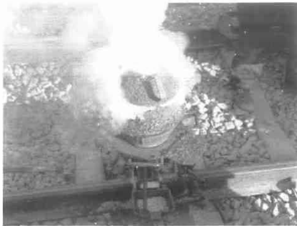
Σχήμα 2.26 Αλουμινοθερμικές συγκολλήσεις σε σιδηροτροχιές
