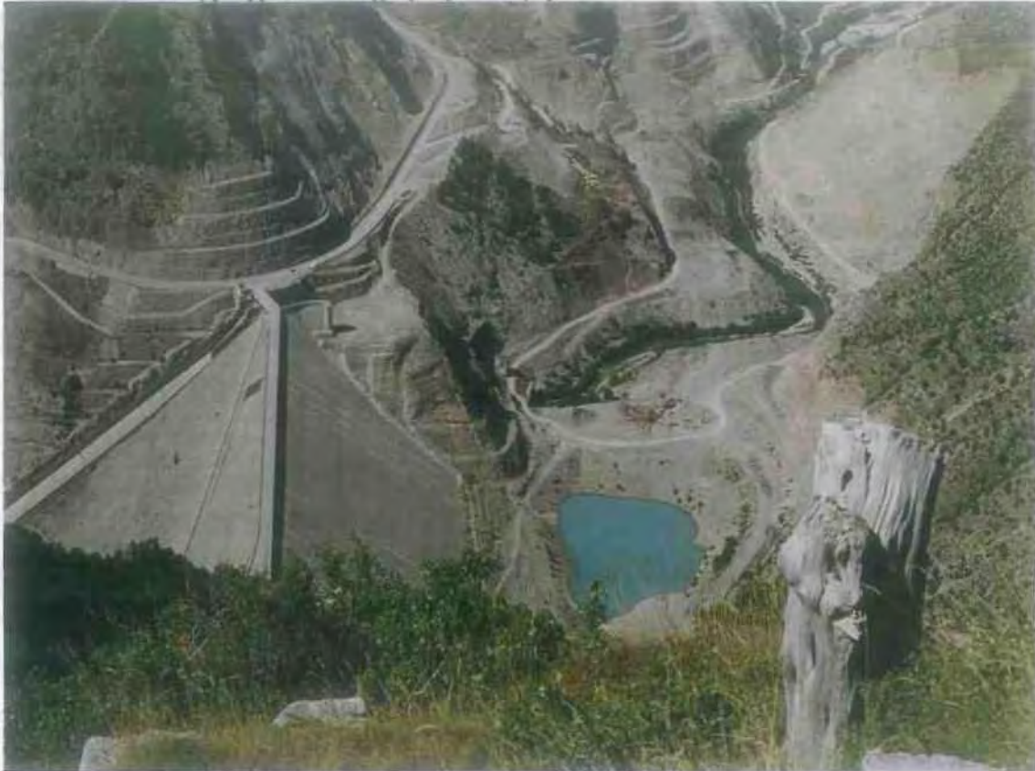
Εικόνα 11: Το φράγμα Μεσοχώρας από ψηλά
