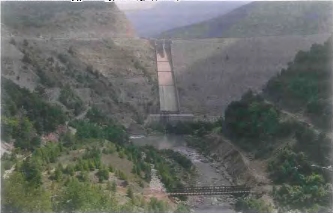
Εικόνα 13: Ο υπερχειλιστής του φράγματος
