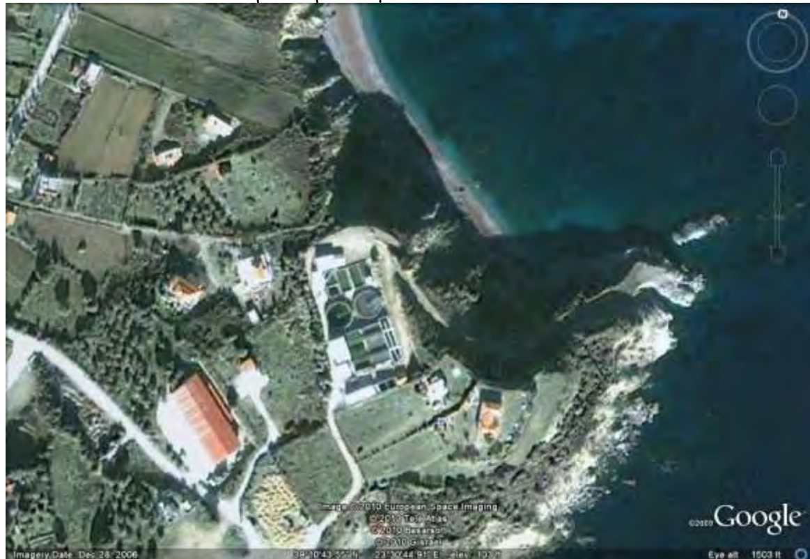
Εικόνα 3: ΕΕΛ Σκιάθου στην θέση 'Ξάνεμο'
